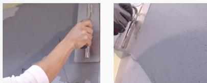
Quitar la cinta protectora antes de que el Microcemento endurezca y dejar secar completamente la segunda capa de Microcemento Base AQUA.
