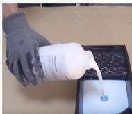
La aplicación del Sellador METALLIC CimentArt siempre será realizada sobre el Microcemento Fino CimentArt con llana de acero o esponja.
